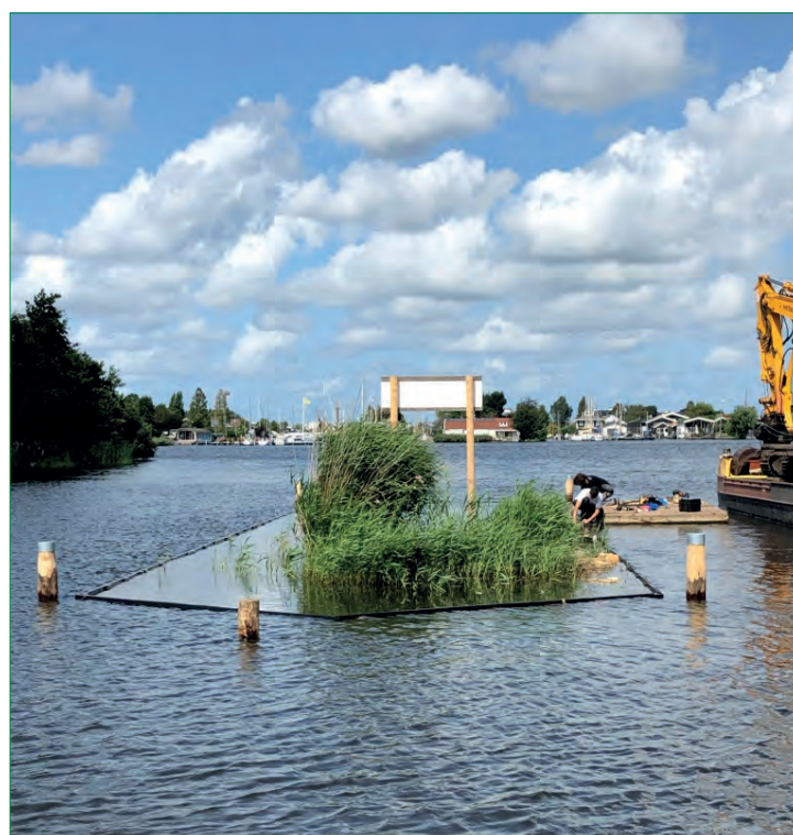
De laatste hand wordt gelegd aan het project Eendengat
