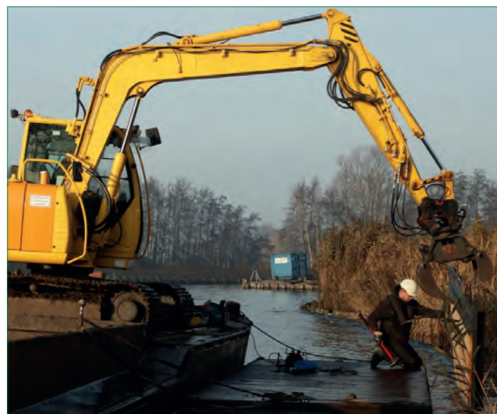
Medewerkers van de firma Otto plaatsen schotten.
