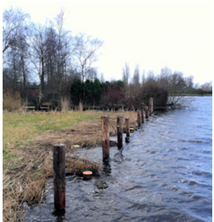
Op de foto: Stand van zaken tijdens de uitvoering van het werk op 4 januari 2012. Na het plaatsen zijn de palen op gelijke hoogte afgezaagd.
