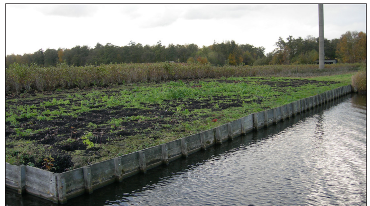
Beschoeiing met Platothout (2007); deze beschoeiing is onlangs vervangen.
