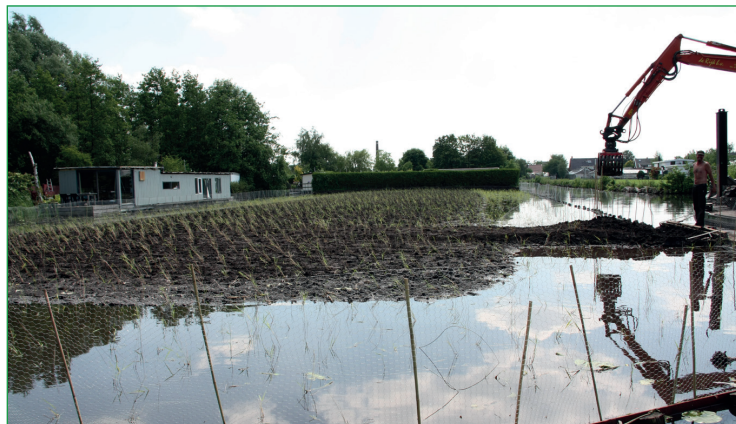
Foto: Rietaanplant op de Pousakker, 6 juni 2014
