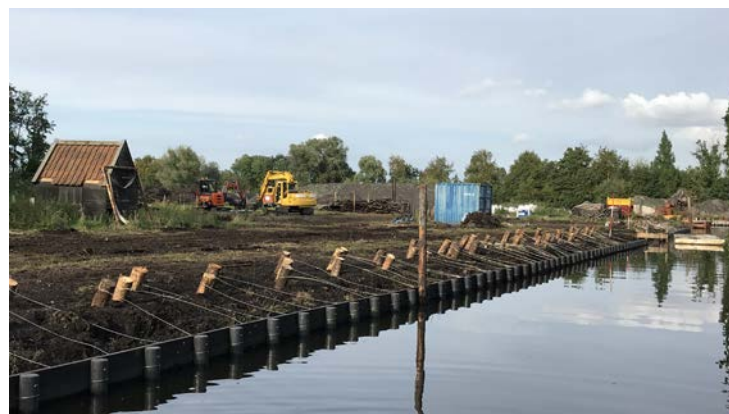
Beschoeiing in aanleg bij locatie 1, zijde Westeinderdijksloot
