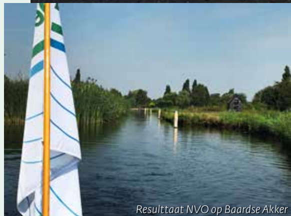
Aanleg NVO op Baardse Akker
